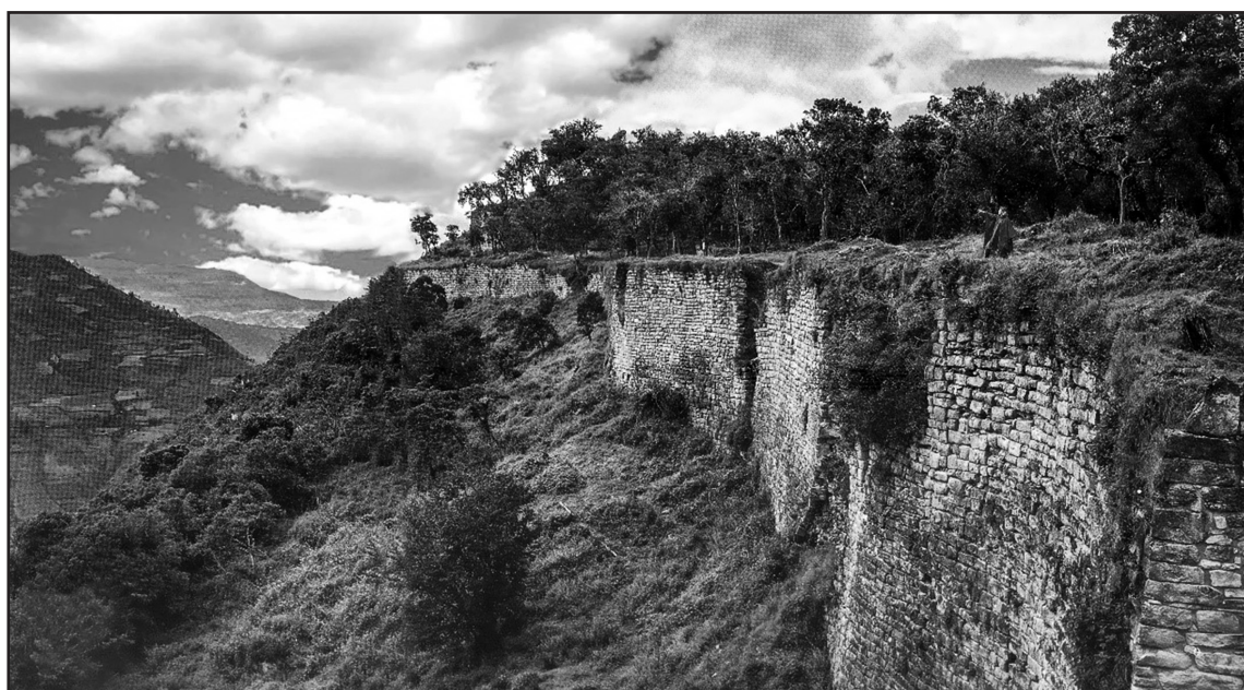
Muro posterior que sostiene la plataforma principal de Kuélap.
